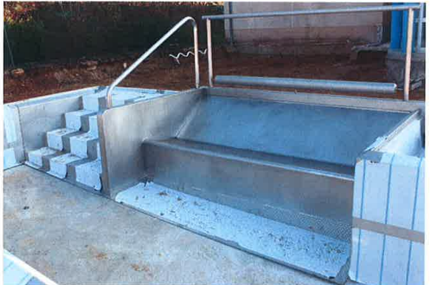
Escalier et banc à bulles en cours de montage
